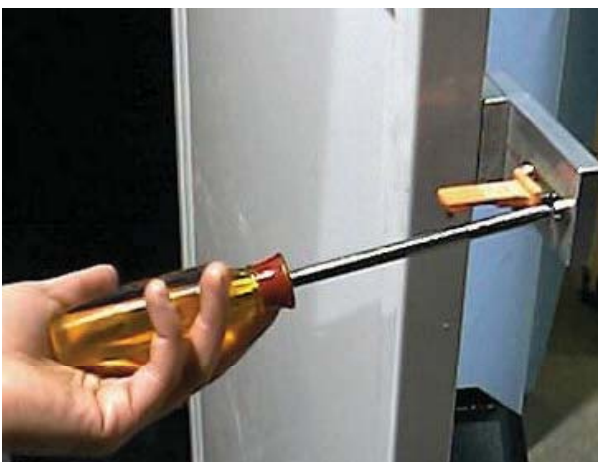
FIG. 12- ADJUST INTERLOCK KEY TAB IF NECESSARY
